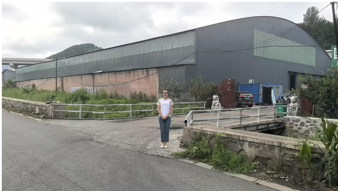
图 2-5 现场踏勘图片
